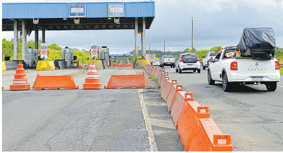
Praças de pedágio, antes administradas pela ViaBahia, estão sob a tutela da ANTT
