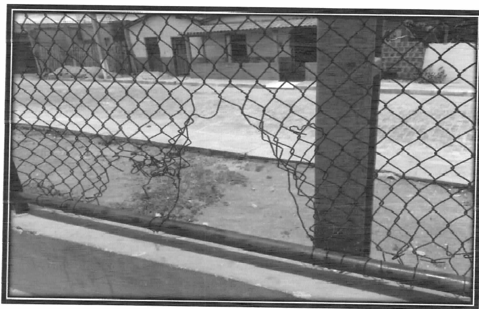
IMAGEM 02 – SITUAÇÃO DA TELA DO ALAMBRADO
