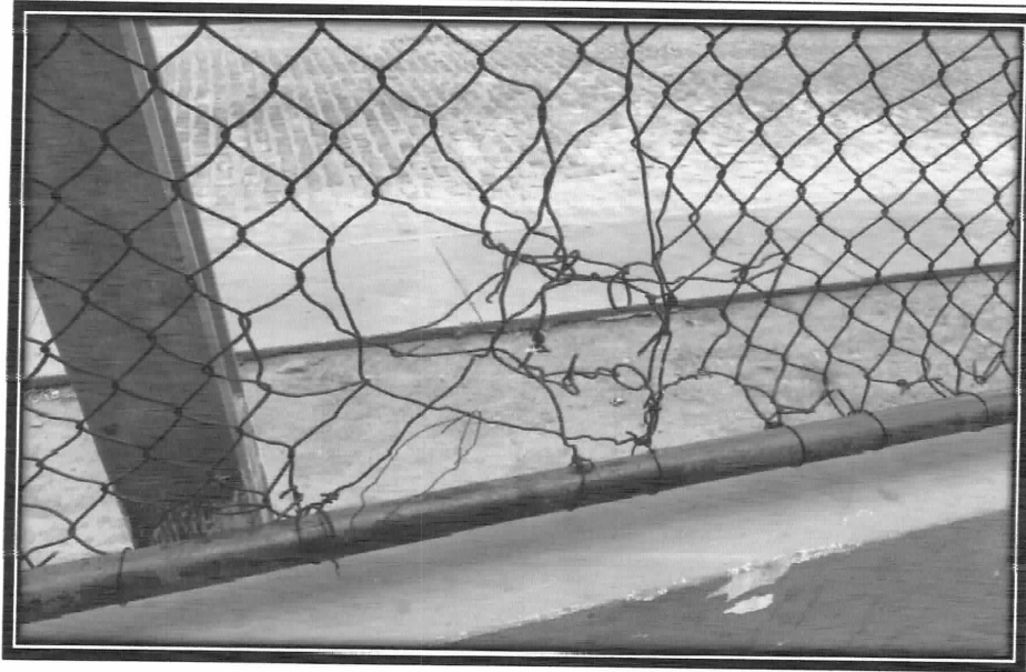
IMAGEM 03 – SITUAÇÃO DA TELA DO ALAMBRADO
