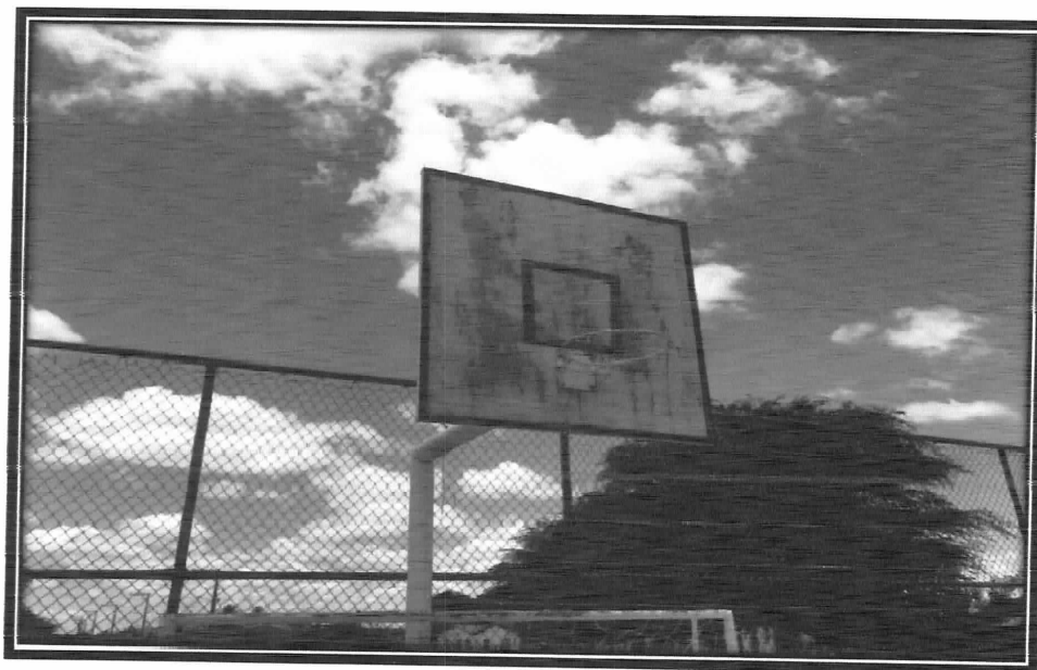
IMAGEM 06 – ESTRUTURA FIXA DE BASQUETE QUE SERÁ RESTAURADO
