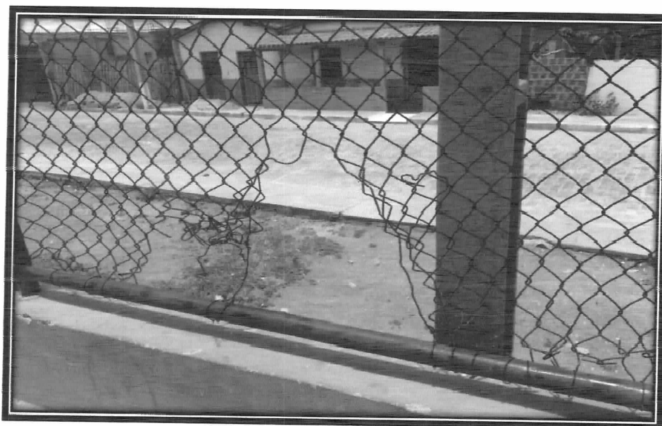
IMAGEM 02 – SITUAÇÃO DA TELA DO ALAMBRADO
