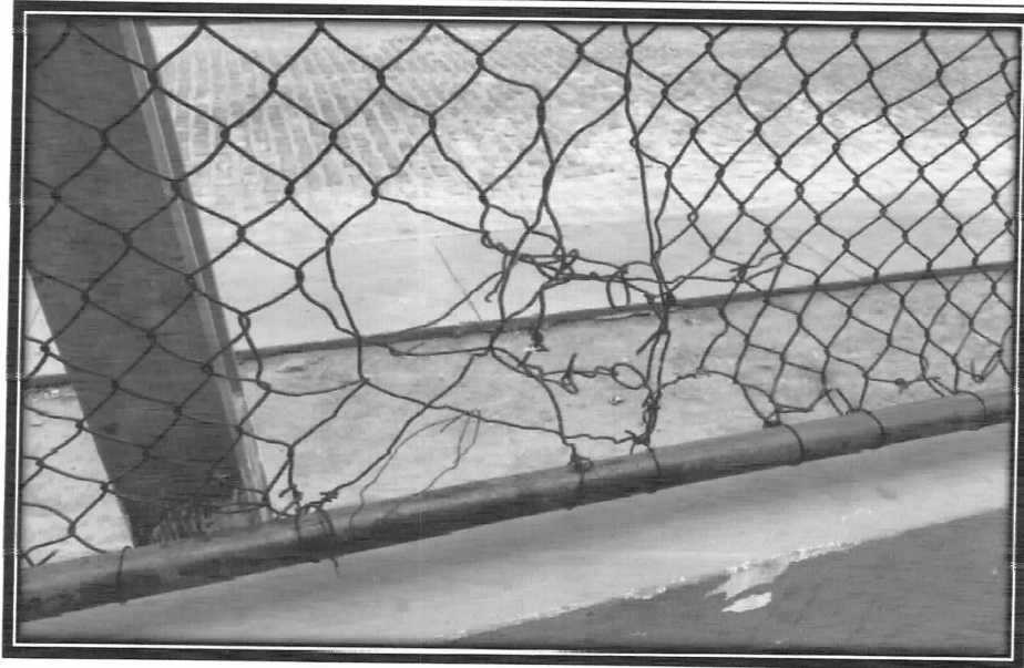
IMAGEM 03 – SITUAÇÃO DA TELA DO ALAMBRADO
